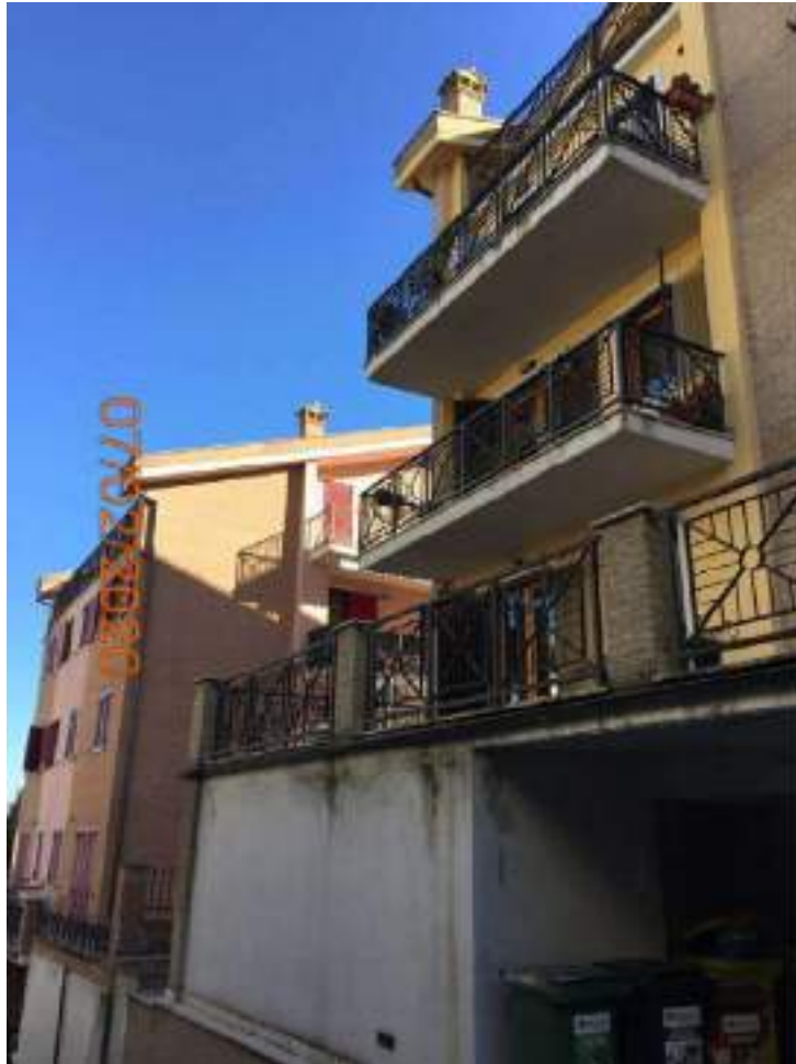
Vista Palazzine Via Marzabotto
