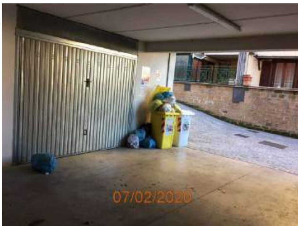
Vista garages via Marzabotto
