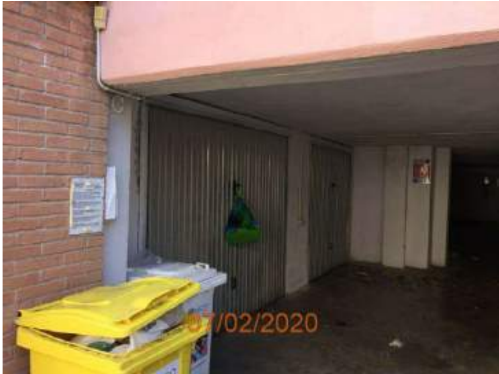
Vista Garages Via Marzabotto
