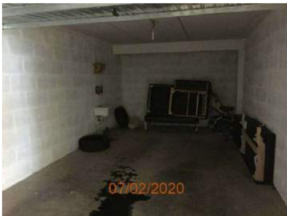
Vista Garages Via Marzabotto
