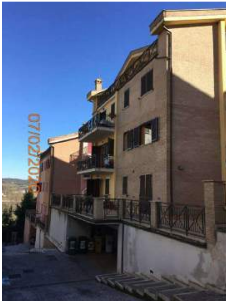
Vista Palazzine Via Marzabotto
