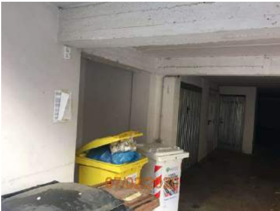
Vista Garages Via Marzabotto
