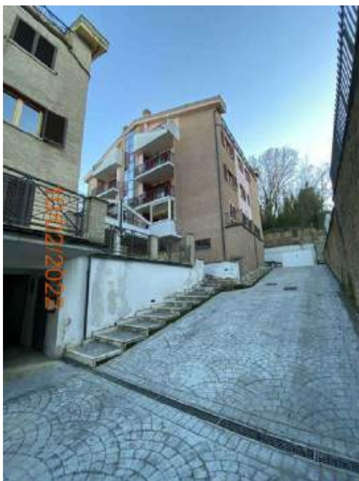
Vista Palazzine Via Marzabotto
