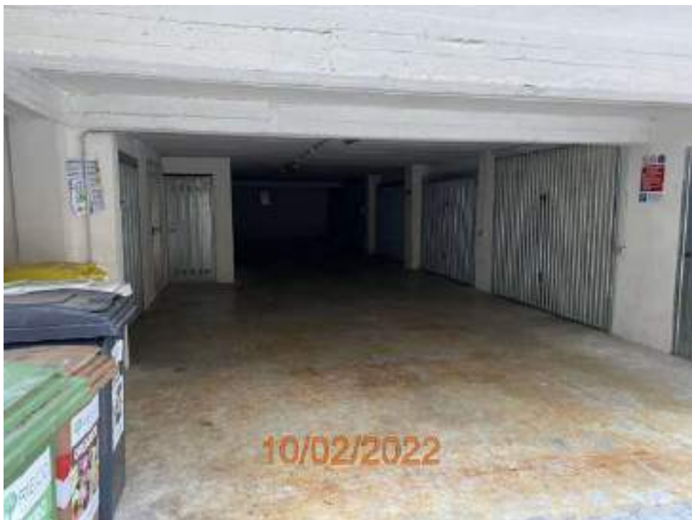
Vista Garages Via Marzabotto
