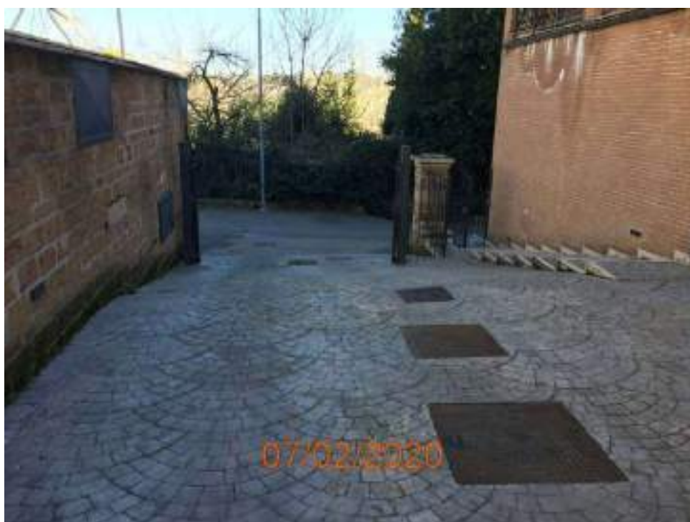
Vista rampa via Marzabotto
