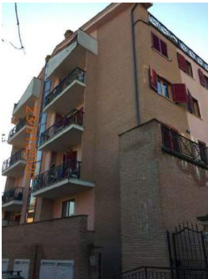
Vista Palazzine Via Marzabotto
