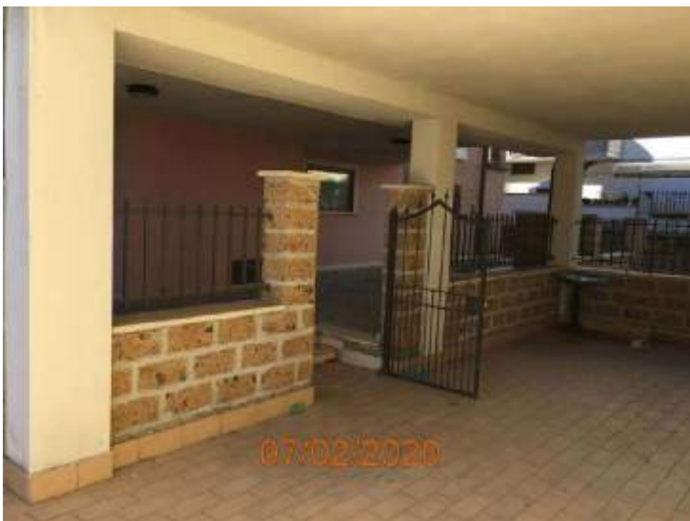
Ingresso area est. App.to F. 56, P.lla 611, Sub. 27
