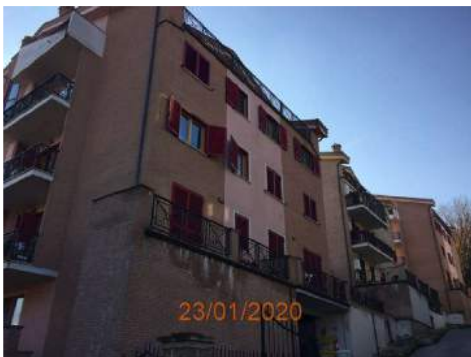
Vista Palazzine Via Marzabotto
