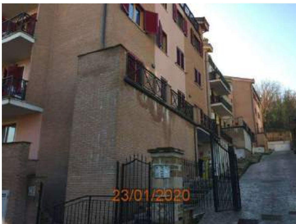
Vista Palazzine Via Marzabotto
