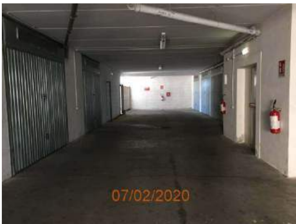
Vista Garages Palazzina Largo Geremia Subiaco
