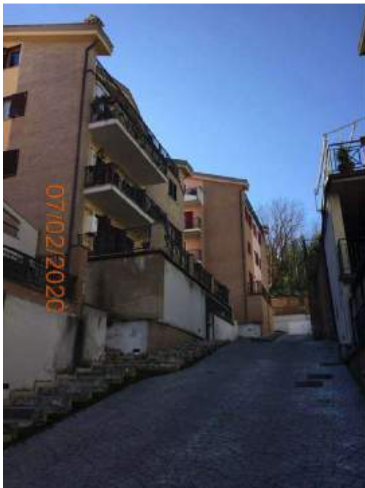
Vista Palazzine via Marzabotto
