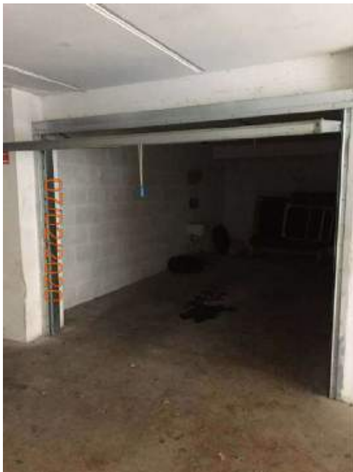
Vista Garages Via Marzabotto
