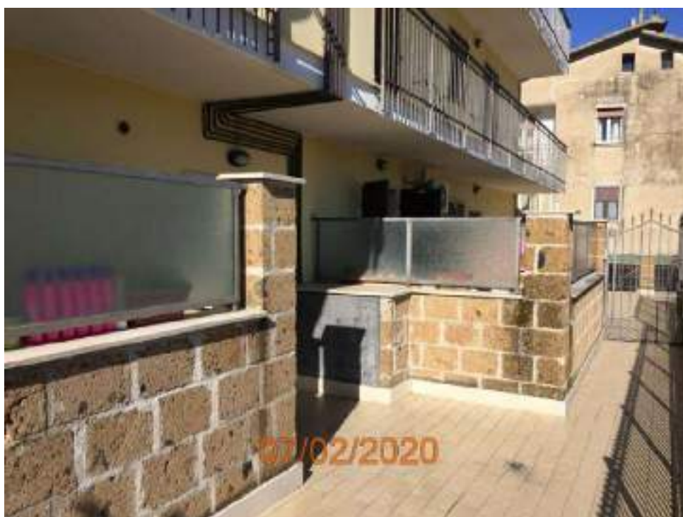
Area Est. condominiale di accesso - L.go Padre G. Subiaco
