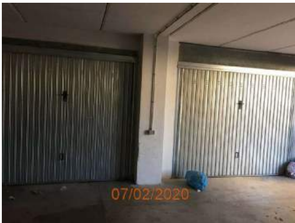
Vista garages via Marzabotto
