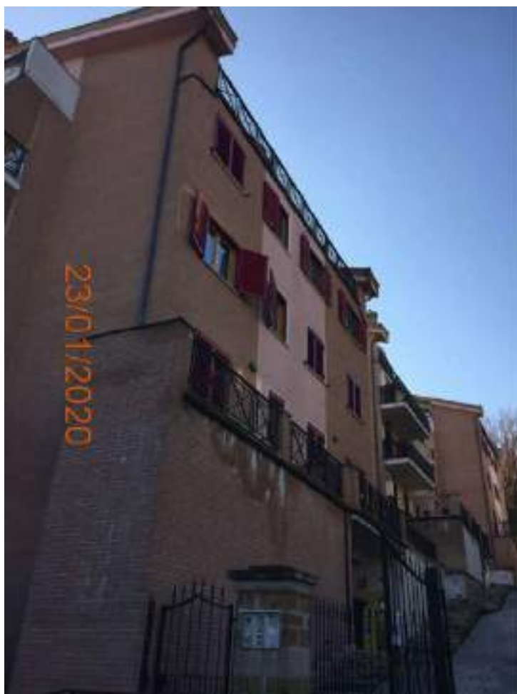
Vista Palazzine Via Marzabotto
