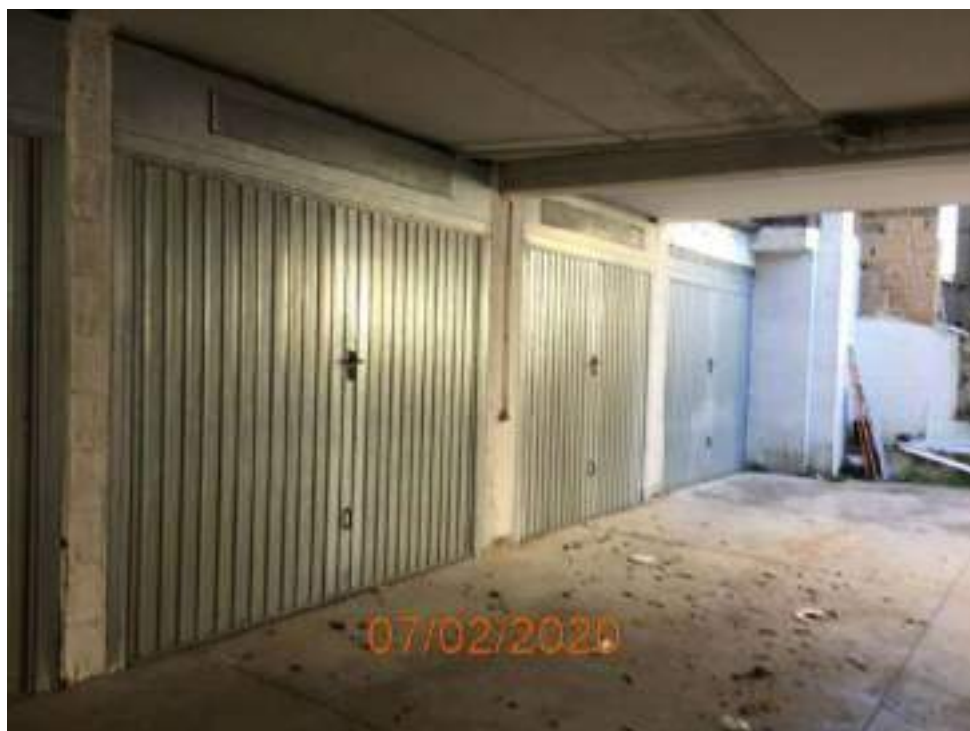
Vista Garages Palazzina Largo Geremia Subiaco
