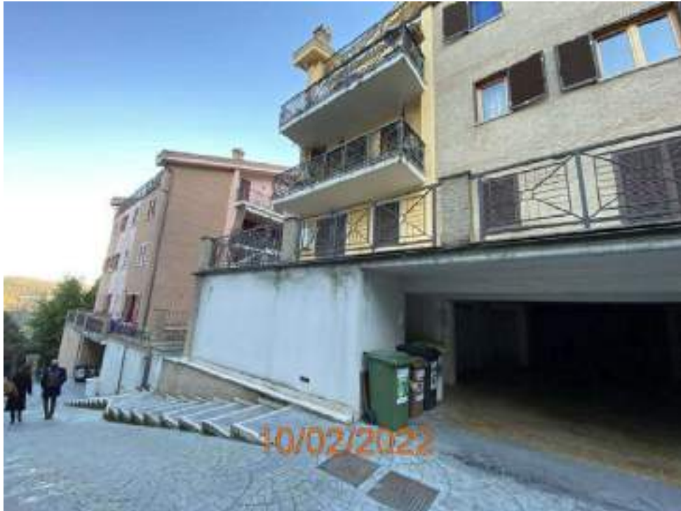
Vista Palazzine Via Marzabotto
