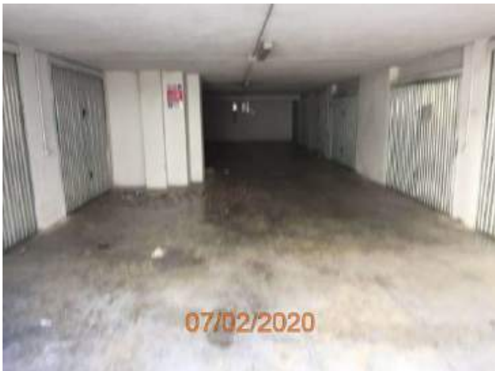
Vista Garages Via Marzabotto
