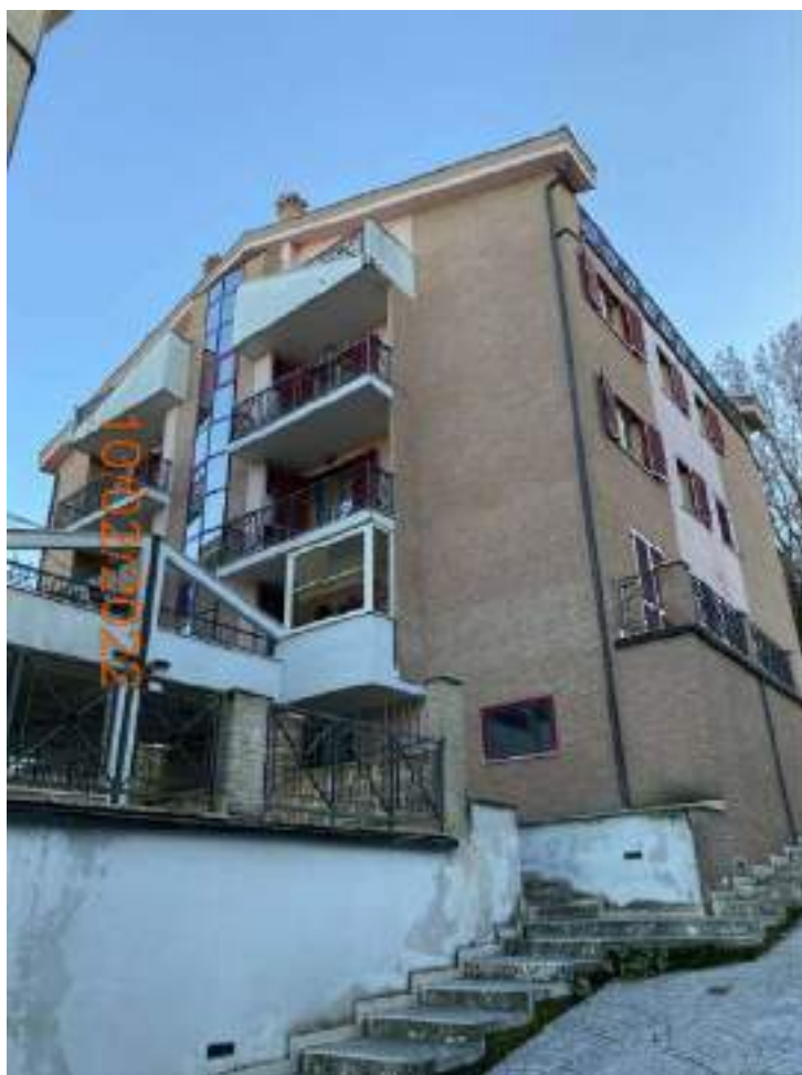
Vista Palazzine Via Marzabotto
